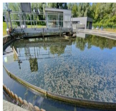
4 Clarificateur séparation des micro-organismes agglomérés sous forme de boues
