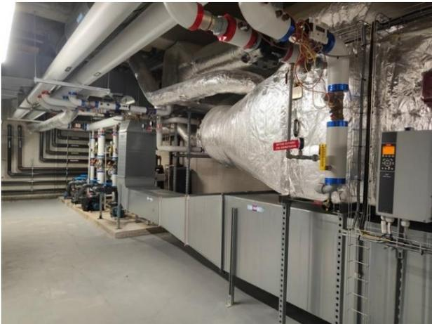
Figure 1 Centrale de traitement de l'air
