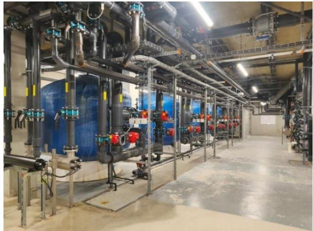
Figure 2 Filtres à sable traitement de l'eau 1 par bassin
