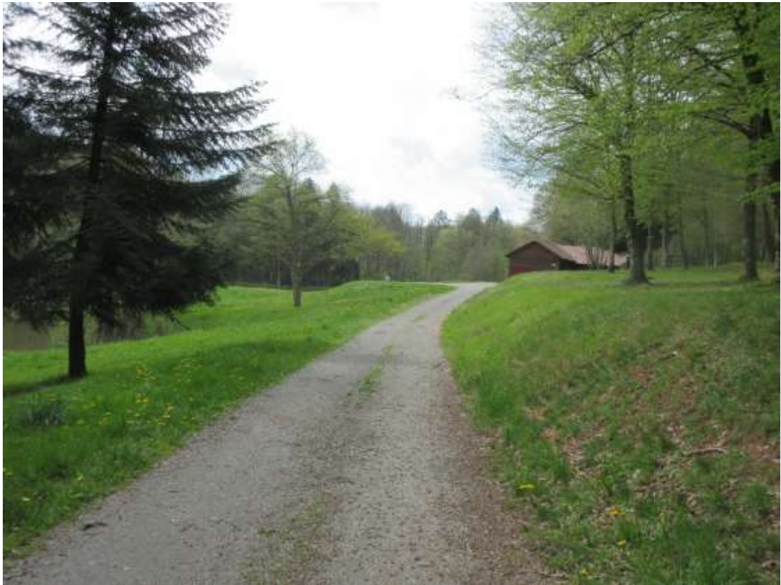
Etueffont : base de loisirs
